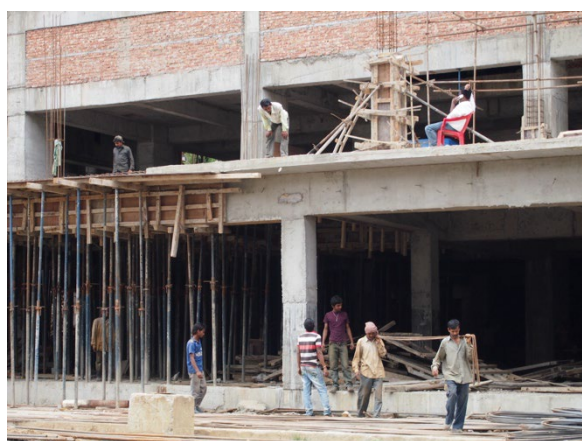
図8. 建設現場で働くインド人労働者 (2013年7月筆者撮影)
