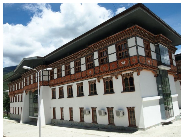
図9. Thimphu TechPark外観 (2013年7月筆者撮影)
